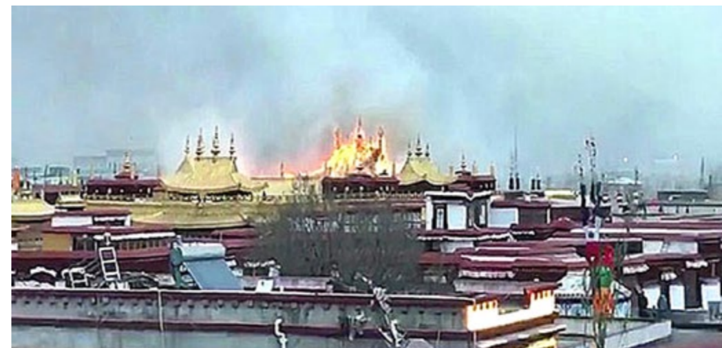
Meterhoch schlugen die Flammen am 17. Februar aus dem Dach des Jokhang-Tempels. Quelle: RFA
